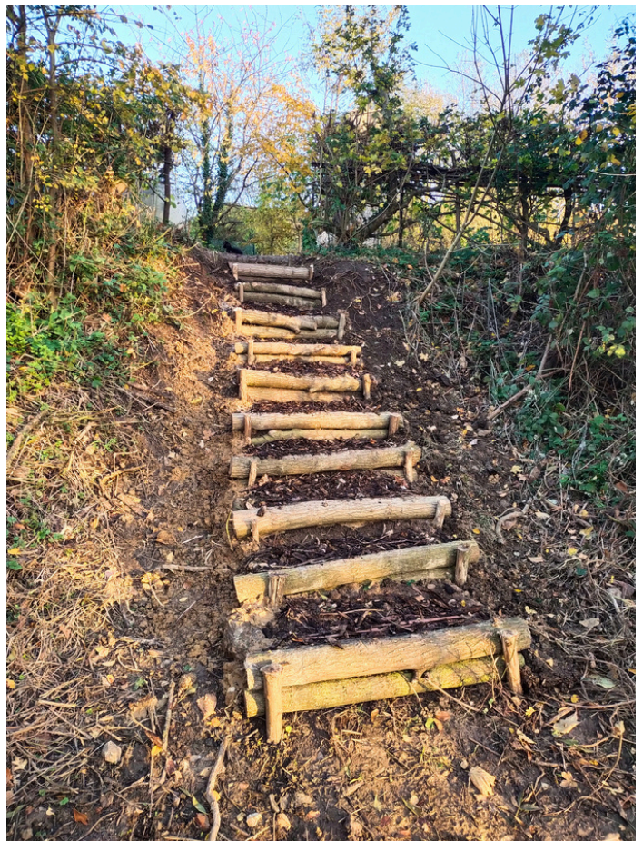
Première étape. la construction de l'escalier d'accès.
